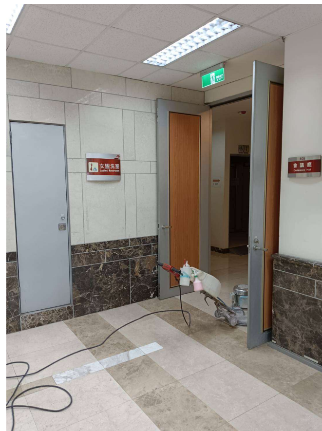
【圖書館六樓東側施工處現場】
